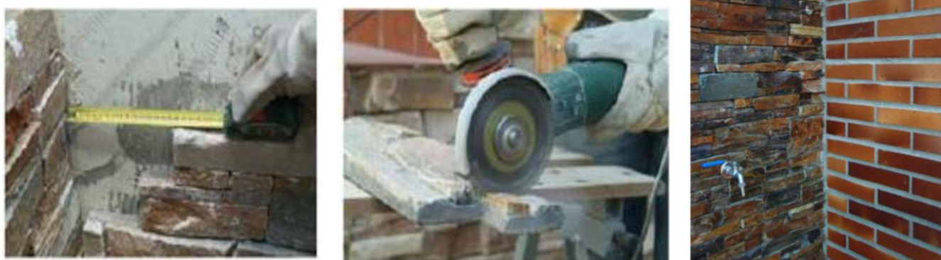
Figure 7 – Réalisation d'un angle rentrant
