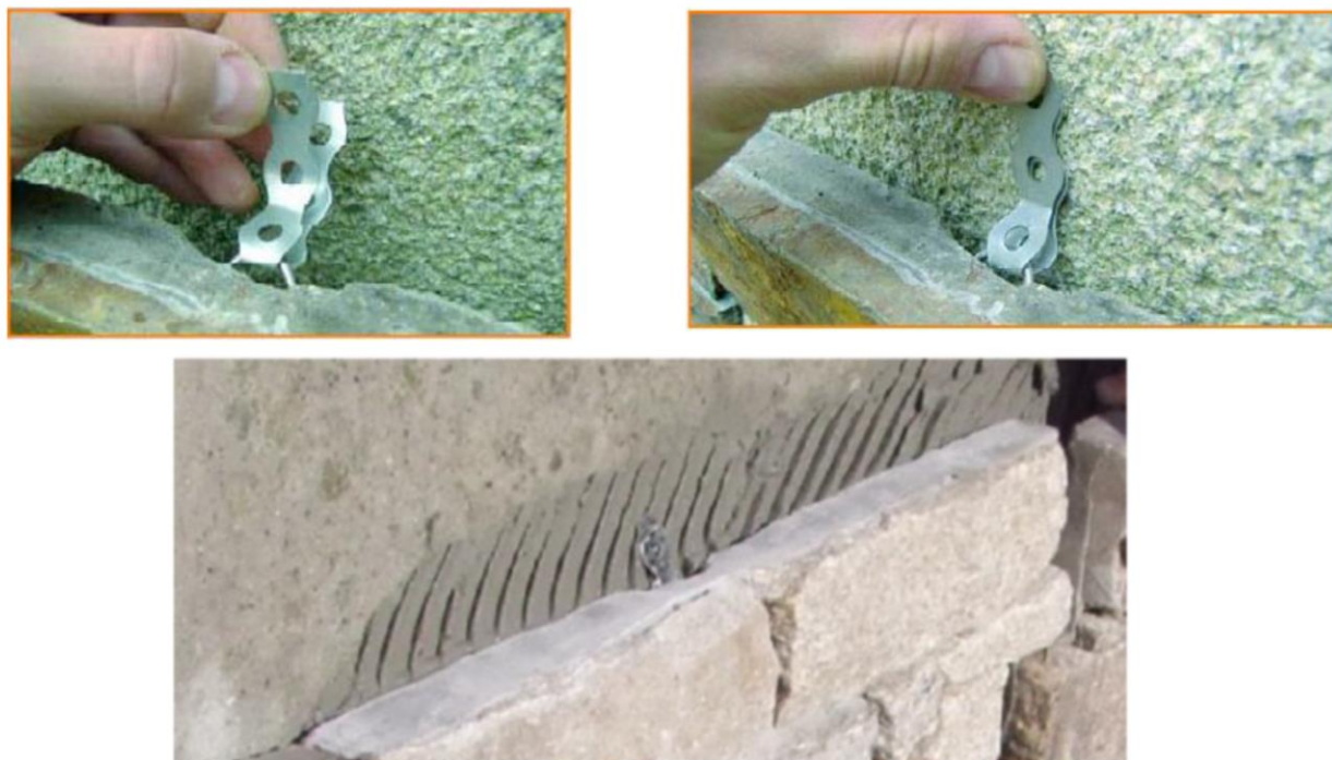
Figure 6 – STONEPANEL SKY : Mise en œuvre de l'élément de sécurité
